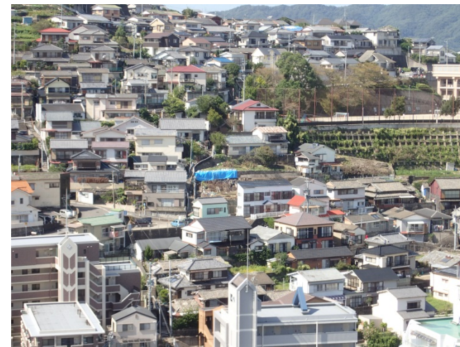
上田町(急傾斜地の崩壊予防対策)
