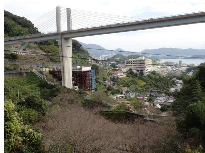
芒塚町(土石流・崩壊の復旧対策施設)
