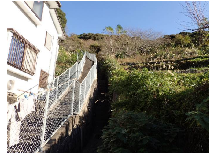
鳴滝1丁目(土石流の復旧対策施設)
