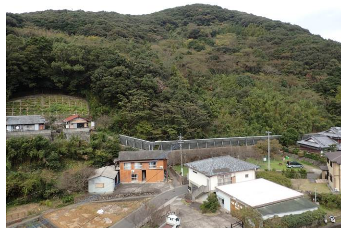
本河内4丁目(崩壊の復旧対策施設)
