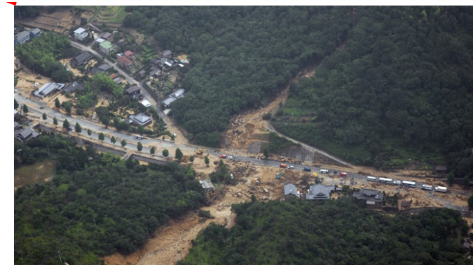
平成21(2009)年豪雨災害の土石流被害の状況 (防府市勝坂地区)
