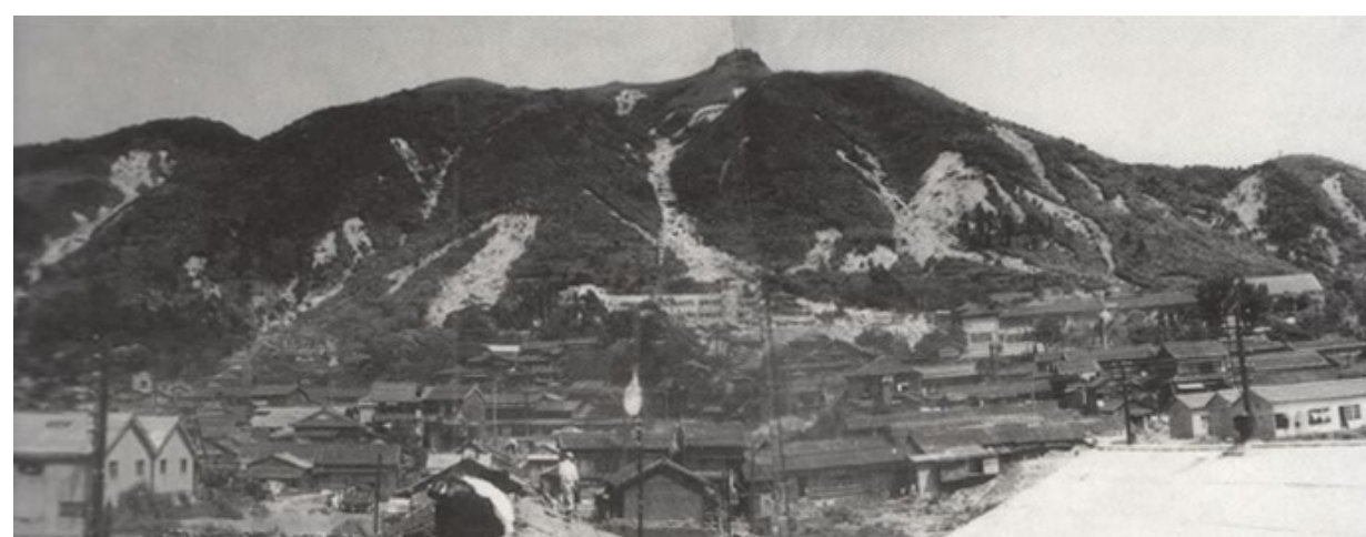
昭和28(1953)年西日本水害の状況 (風師山の山腹崩壊)
