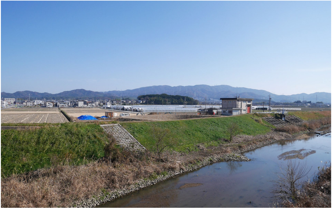
写真 3-3 菱池干拓地を流れる広田川(周囲に排水機場が整備されている)
