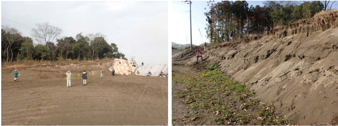
写真 3-4 若宮戸地区の河畔砂丘（左：全景，右：拡大, 2015 年 12 月 11 日撮影）
