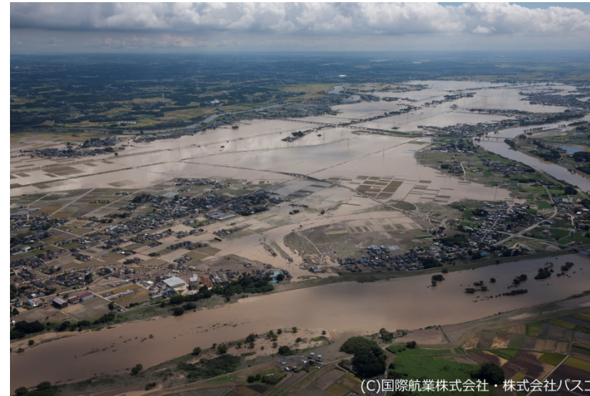
上三坂地区の破堤箇所およびそれより南方の状況
