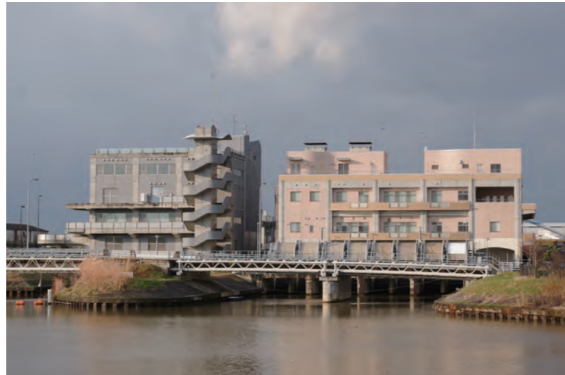
24時間新潟を守る親松排水機場と鳥屋野潟排水機場 (2017年12月23日撮影)
