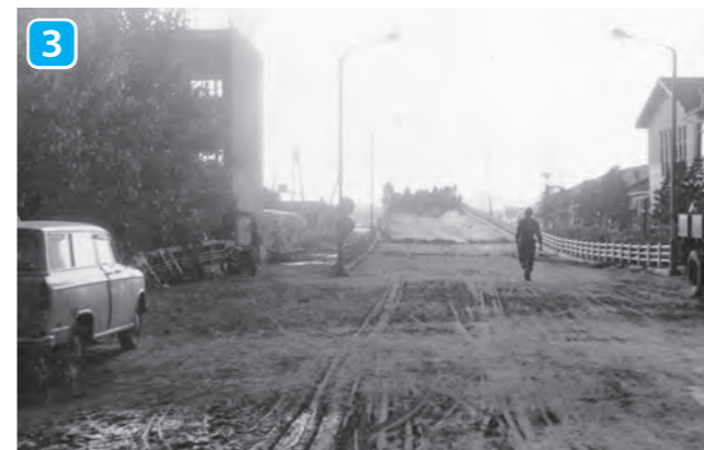
八千代橋右岸 自衛隊による補修作業 新潟市中央区八千代付近 出典：(研)防災科学技術研究所:1964年新潟地震オープンデータ特設サイト, (2017.11.14),(研)防災科学技術研究所,http://ecom-plat.jp/19640616-niigata-eq
