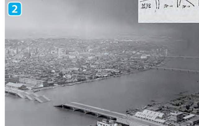
昭和大橋の落橋 新潟市中央区一番堀通町付近 出典：(研)防災科学技術研究所:1964年新潟地震オープンデータ特設サイト, (2017.11.14),(研)防災科学技術研究所,http://ecom-plat.jp/19640616-niigata-eq
