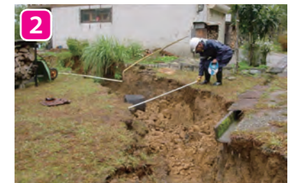
2 鶴ヶ丘団地の地割れ 長岡市乙吉町付近 出典：新潟県ホームページ「新潟県中越地震の記録」
