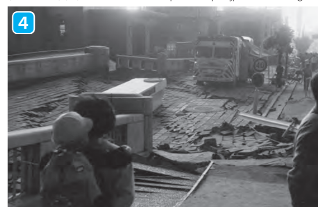
萬代橋右岸 地盤の変状 新潟市中央区万代付近 出典：(研)防災科学技術研究所:1964年新潟地震オープンデータ特設サイト,(2017.11.14),(研)防災科学技術研究所,http://ecom-plat.jp/19640616-niigata-eq
