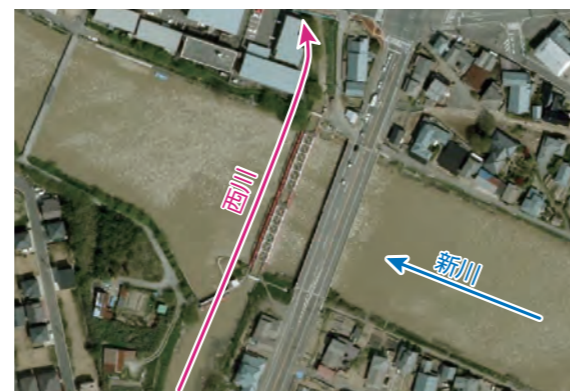
現在の新川と西川の立体交差部分。 航空写真：国土地理院「地理院地図(地理院タイル)」より
