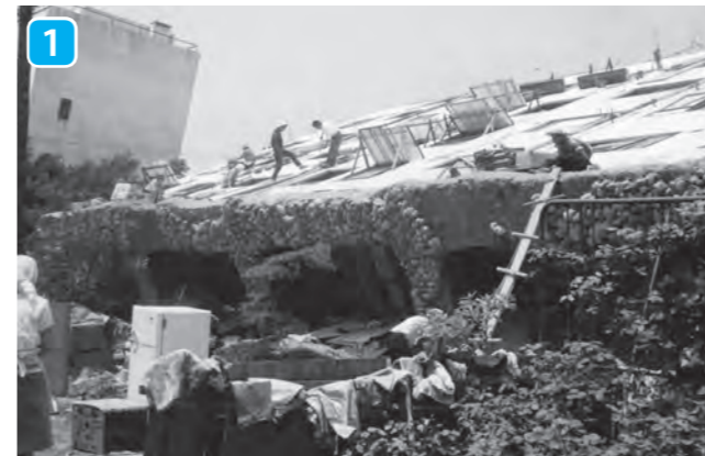
傾斜した県営アパート 新潟市中央区川岸町付近 出典：(研)防災科学技術研究所:1964年新潟地震オープンデータ特設サイト, (2017.11.14),(研)防災科学技術研究所,http://ecom-plat.jp/19640616-niigata-eq
