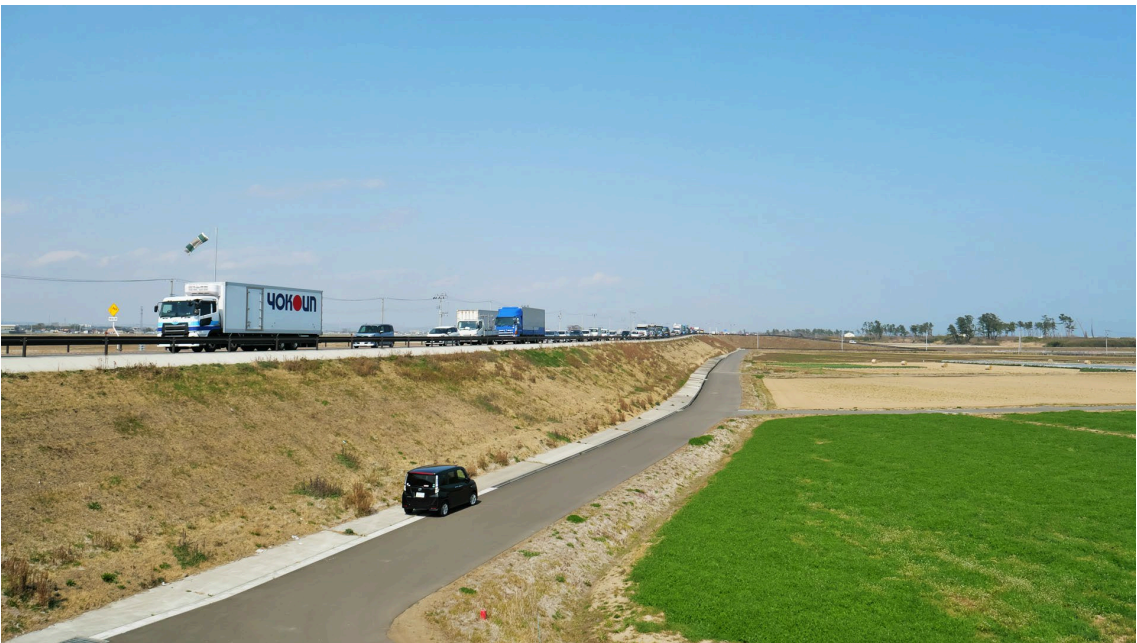
写真 3-9 かさ上げ道路(東部復興道路)
