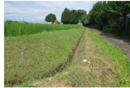
巻江とは上の田の余った水や漏れた水を集めて下の田などに供給する小さな用水。
