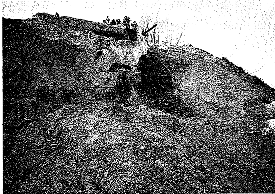
写真4 西川町綱取の地すべり。 1983年4月18日発生。滑落崖をはさんで伸縮計が設置されている。
