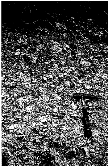
写真一 鮭川村西郡の西郡川左山岸地に見られる地すべり崩積土
