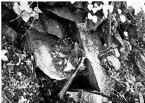
写真－2 遅沢地すべり地の崩積土にみられる冷気を吹き出す「風穴」
