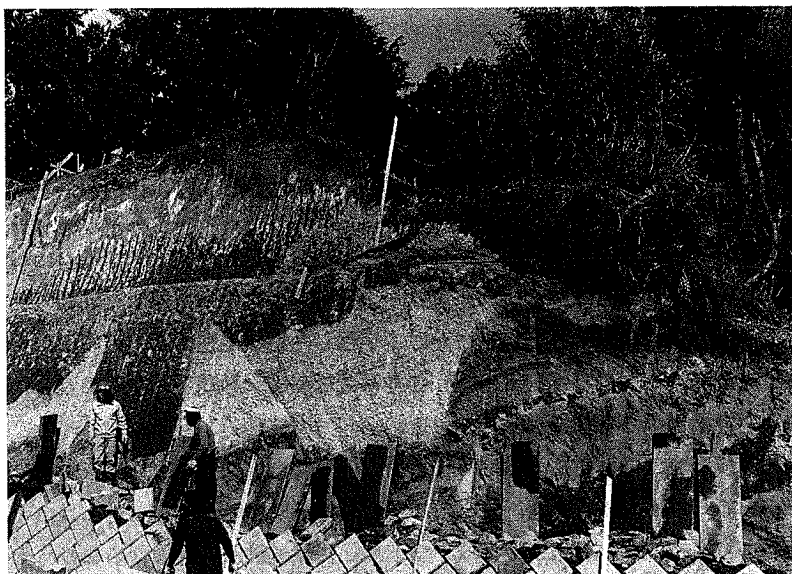
国府津駅北の農道工事で現れた国府津－松田断層の露頭。白い石英安山岩質軽石流（p）が、ずたずたに切られており、同軽石流堆積後の大磯丘陵の激しい地殻変動を示している。
