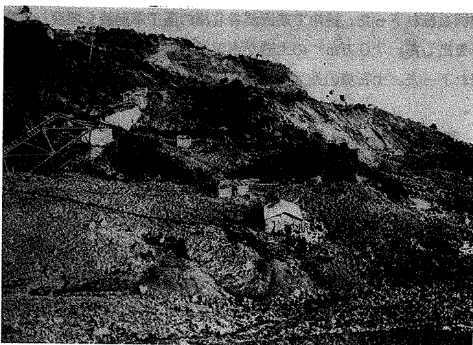
関東大地震による白糸川土石流と根府川駅後方の地すべり（同上より） 手前：土石流堆積物 左：熱海線（現東海道線）の落ちた鉄橋 後方：根府川駅背後の地滑り面
