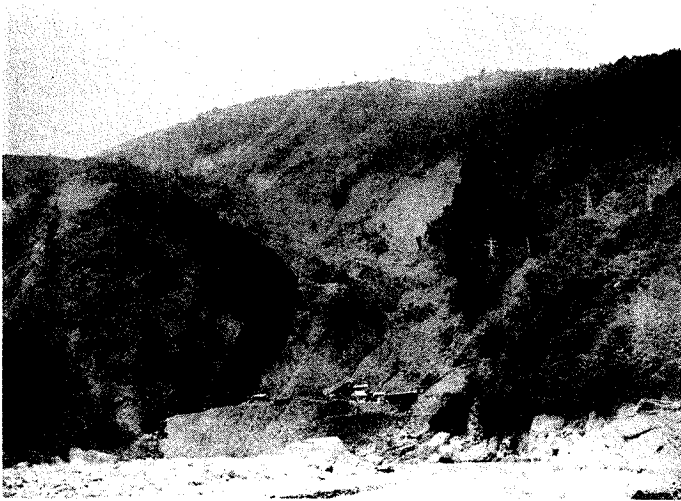
写真1 東海道線谷峨駅東方の土石流（関東大地震）
