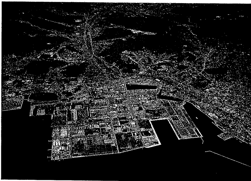
写真7 蒲郡市街地西部から形原町付近の斜め航空写真(蒲郡市役所提供) 写真中央下部は大干拓造成地、右手は遠峰山地と南麓域、中央は東海道本線が通る捨石川低地、左手は三ヶ根山の北東山麓である。北西方向を望む。
