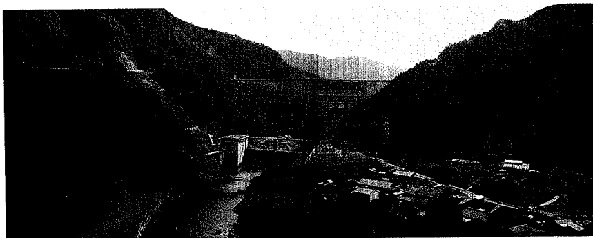
写真8 矢作川と矢作第一ダム堰堤 岐阜県恵那郡串原村閑瀬東方より、南々東方向を望む。集落の立地している所は矢作川が形成した低位段丘面である。矢作第一ダムは奥矢作湖を函養する多目的ダムであり、それ自身で発電すると共に、奥矢作揚水発電所の下池の役割りもなしている。
