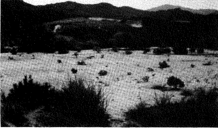
写真1 マサ化した花崗岩質岩石地帯における住宅団地の造成。 (千代田地区額田部)
