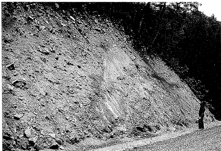
写真5 比和町三河内付近に見られる土石流堆積物の累積
