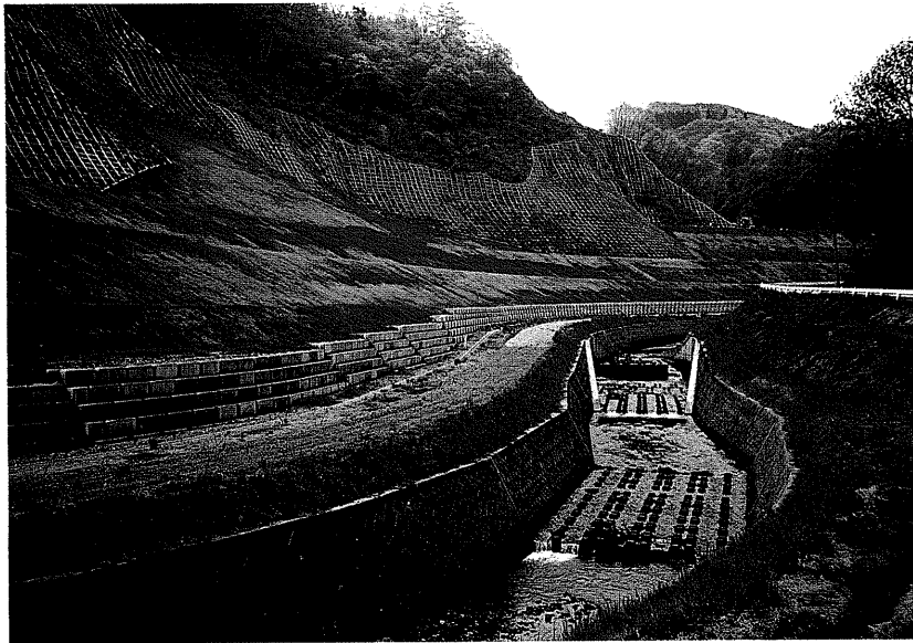
写真3-4-1 大江町深沢地すべりの対策工
