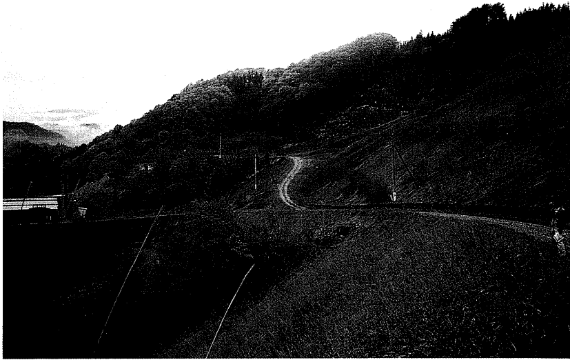
写真3-3-2 小清地すべり
