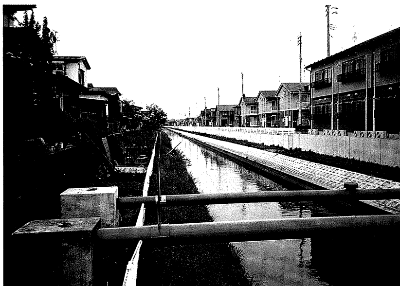
写真4-3-1 赤川旧河道上に造成された住宅地
