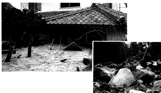
昭和62年10月 台風19号被害 (詫間町須田地区の土石流被害)
