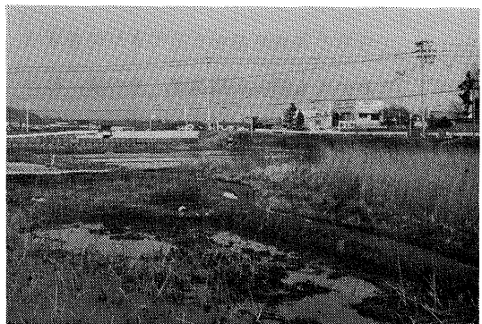
図3-2-3-13 鉞害陥没田（懸樋の高さが陥没前の水田面）
