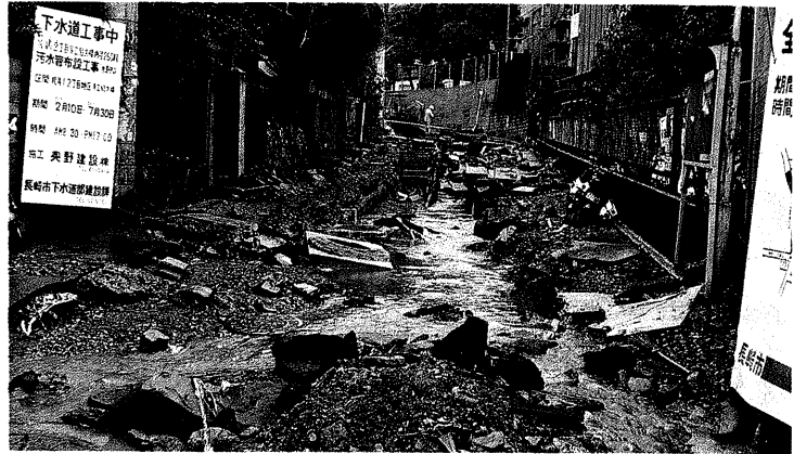
完全に洗い流された通り 71) (鳴滝地区)
