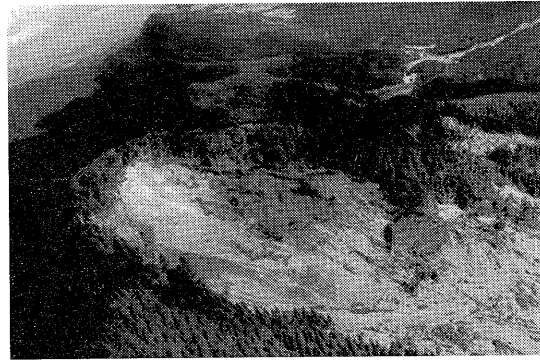
④ 別府田野川 上流部崩壊地 (田野町)
