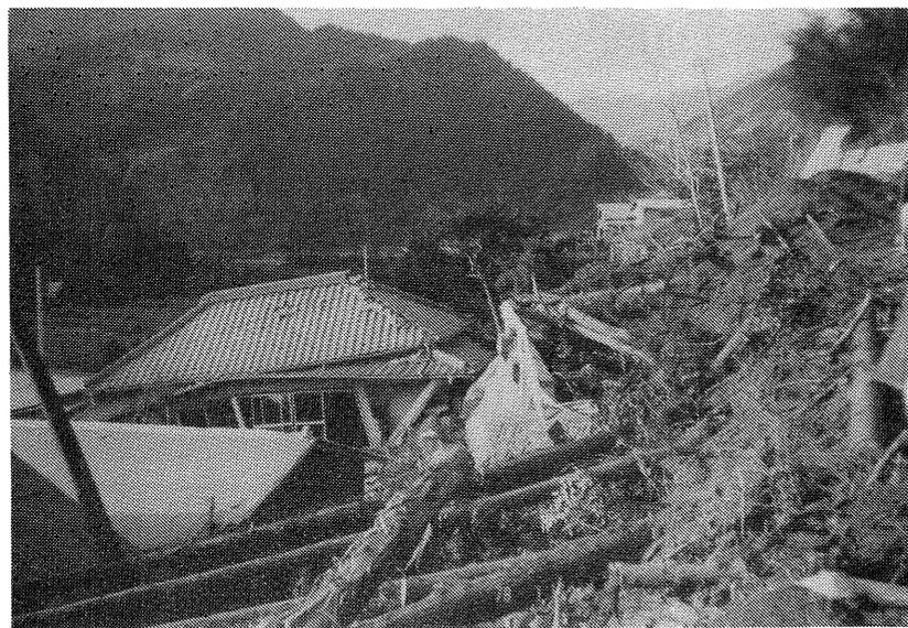
写真5-1 斜面の崩壊によって被害を受けた家屋
