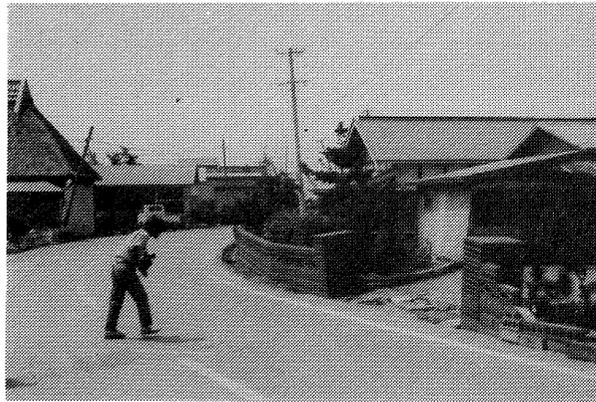
写真4-3 木造家屋の不同沈下(日本海中部地震, 車力村牛潟地区)<sup>(13)</sup>
