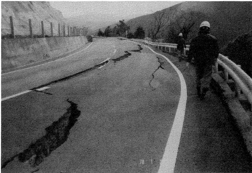
写真 5. - 2 道路盛土端の沈下例
