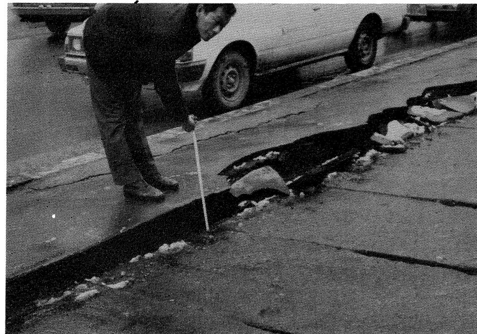
写真 6-1 浦河沖地震における歩道の沈下(浦河町東町)<sup>(10)</sup>
