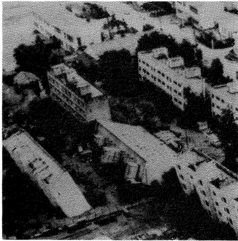
写真4-2 鉄筋コンクリートビルの不同沈下
