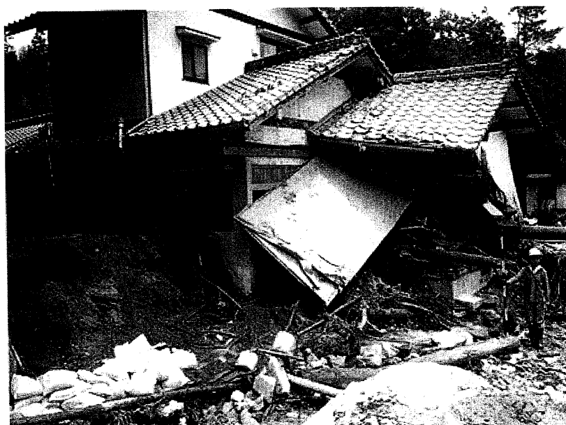
土石流による被害状況（広島県（1999）より転載）
