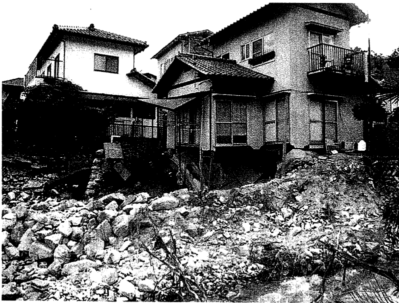
土石流による護岸・家屋の被害状況（広島県（1999）より転載）
