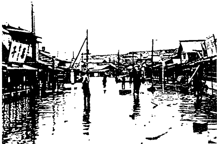
▲渚滑川右岸 渚滑村市街の冠水(現紋別警察署、渚滑駐在所付近)
