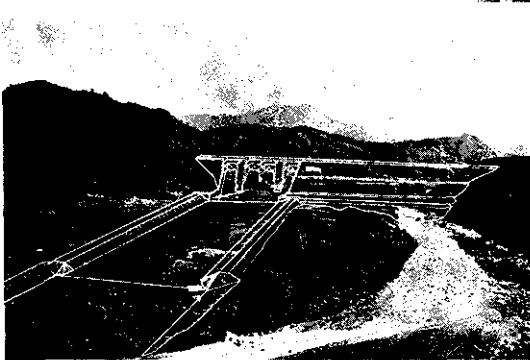
写真-5 御 所 ダ ム 建 設 予 定 地
