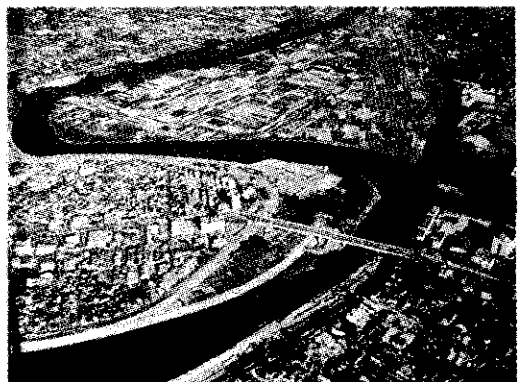
下流域（豊橋市・吉田大橋付近）
