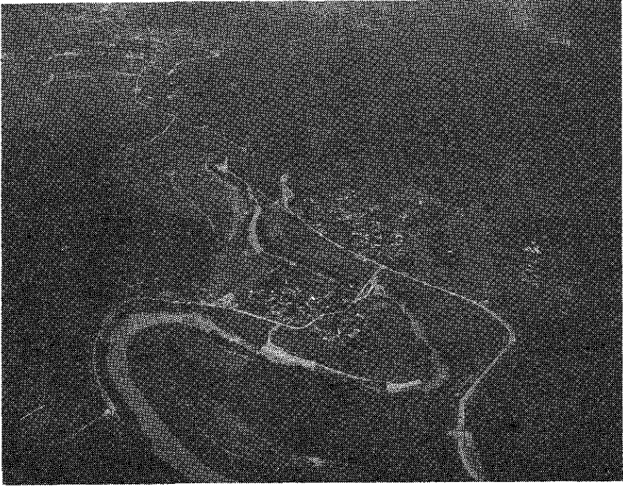
( 工事中の駒鳴捷水路 )
