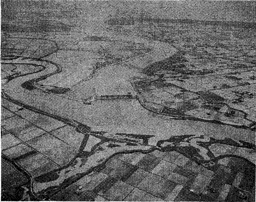
(建設中における六角川河口堰)
