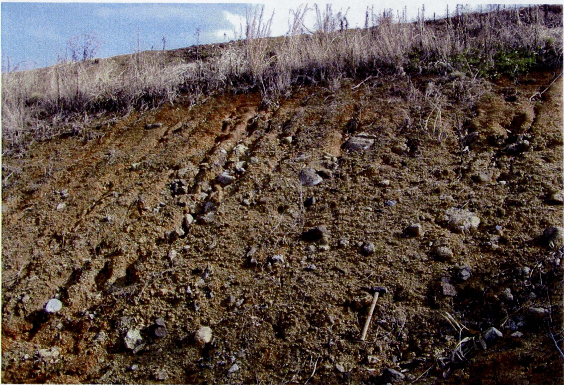
写真3-3 高位段丘の礫層がみられる切土斜面 (岩邑中学校付近)
