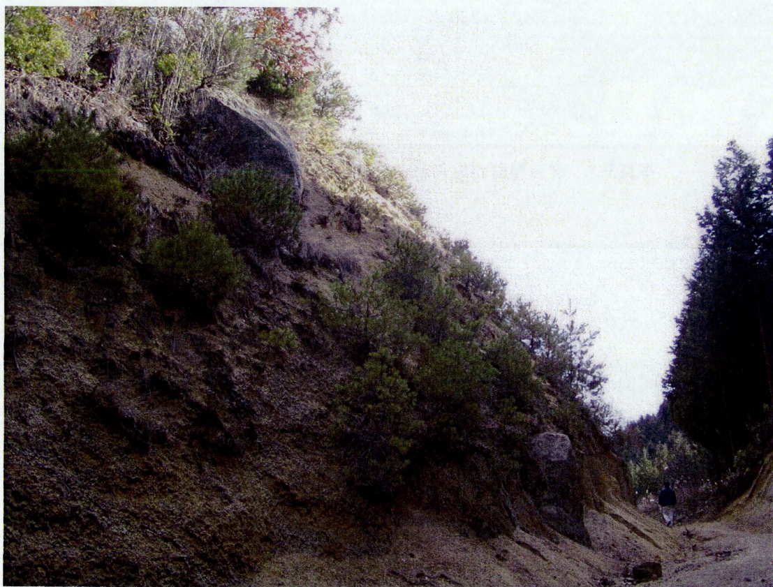
写真3-4 花崗岩類の風化が進みマサやコアストーンがみられる天瀑山付近の切土斜面
