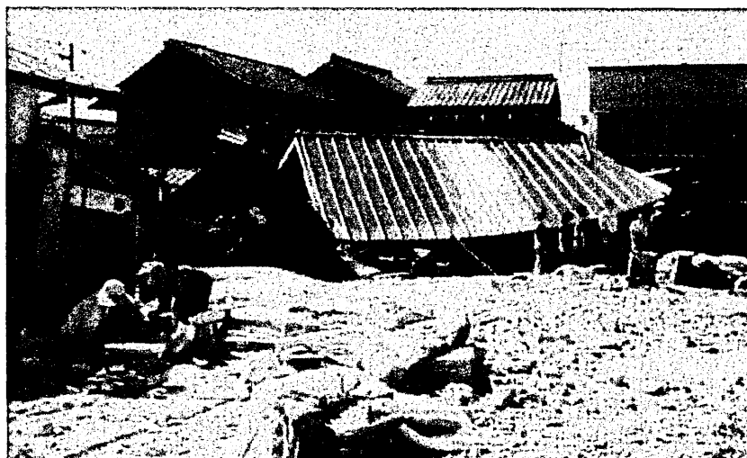
(岐阜県防災・災害のホームページより)
