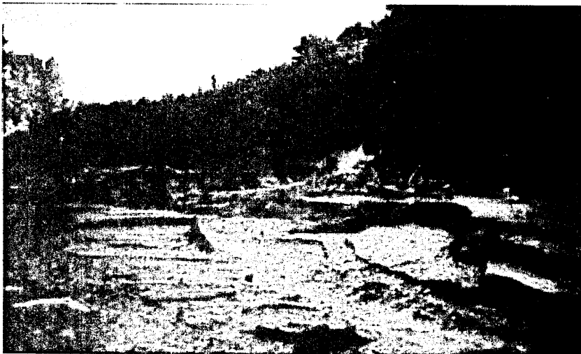
写真5-4 9.20災害で堰堤が決壊した天瀑山溜池
