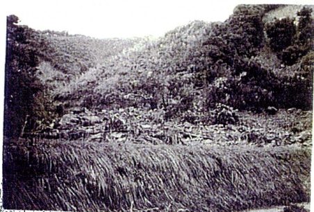
■山崩れ（比木・中田） <写真②>
