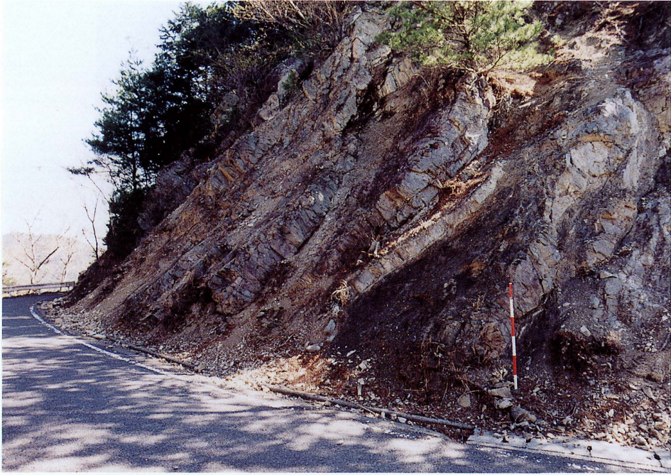
⑬ 野々川最奥、中村市との境界の砂岩勝ち砂岩泥岩互層。砂岩層（灰色）は岩塊状に、泥岩層（黒灰色）は細片状になっている。
