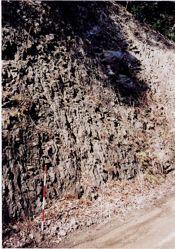
③ 古城本村、石田川上流。泥岩勝ち砂岩泥岩互層で黒灰色を呈し、砂岩・泥岩とも小岩塊・小岩片状に崩れ易い。
