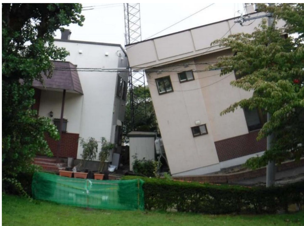
写真 5-2 液状化による不等沈下で傾いた家屋
