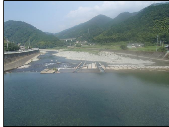
頭首工下流の減水区間
