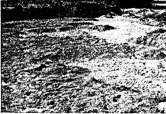
Fig. 11. 宮郷村（圖葉外）広瀬川低地は旧利根川の氾濫原で低地の地下は大型の礫や砂利で充填されており、地上は旧利根川がつくつた自然堤防と呼ばれる脈状の礫堆が広く発達している。広瀬川は旧利根川系の堆積物のほか、側面から供給される赤城火山の火山灰質が礫層の上部を被っている。しかし火山麓から離れた前橋高崎台地寄りには表層の被覆がきわめて薄い。この写真は自然堤防（礫堆）を切りとり均平作業のち、自然堤防上の上層の一部を客土して水田を造成しているところである。
