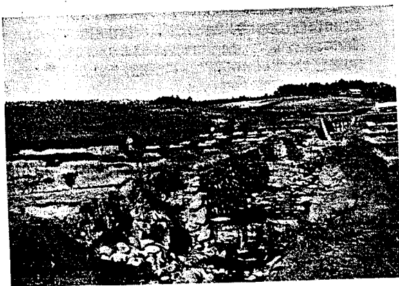
Fig. 16. 北橋村下南室 夏の一回の雷雨による一時的な増水によつて、赤城火山の山麓緩斜面をきざむ放射谷は著しい側蝕を行い、石積護岸を忽ち破壊する。
