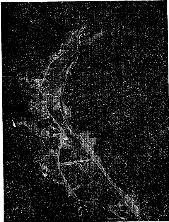
図Ⅲ-3-1 国道162号線上弓削バイパス
