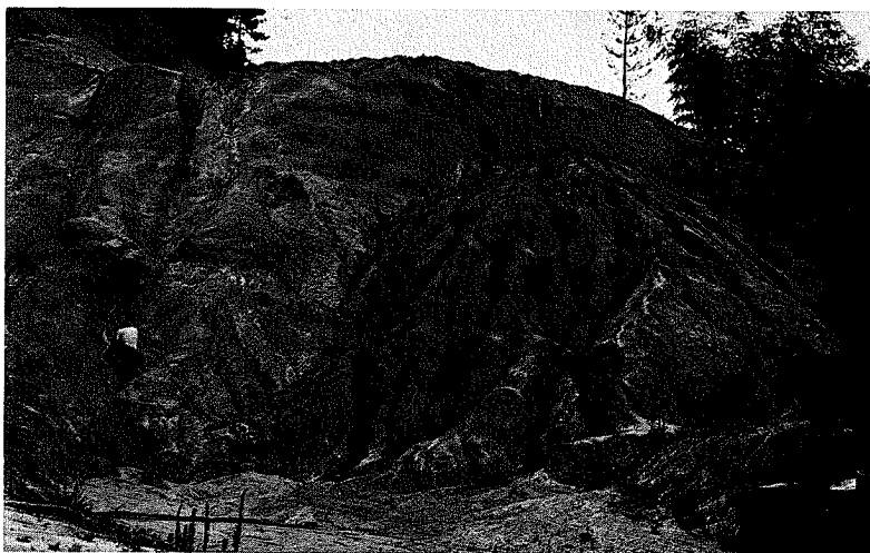
写真3 風化の進んだ花崗岩の露頭—赤色のマサ状になっていて、雨裂もみられる（甲山町別迫付近）。
