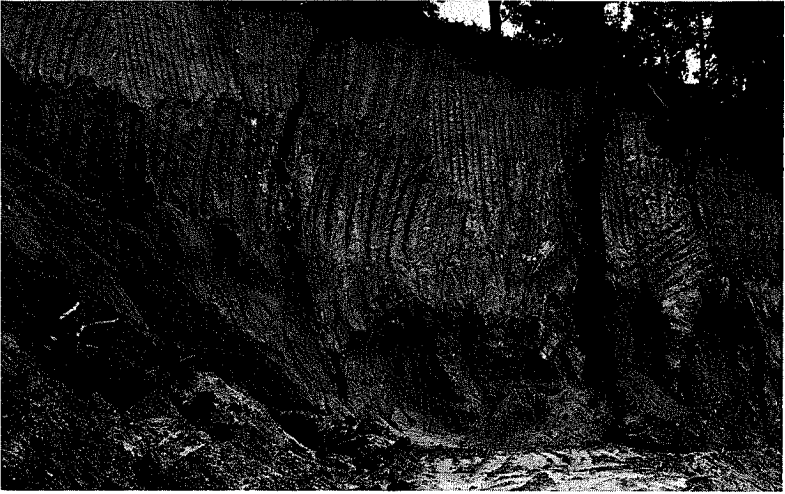
写真 7 風化の進んだ花崗岩—露頭は赤褐色のマサ状になっている。 縦縞はブルドーザーの爪のあとを示す（上下町水永）。
